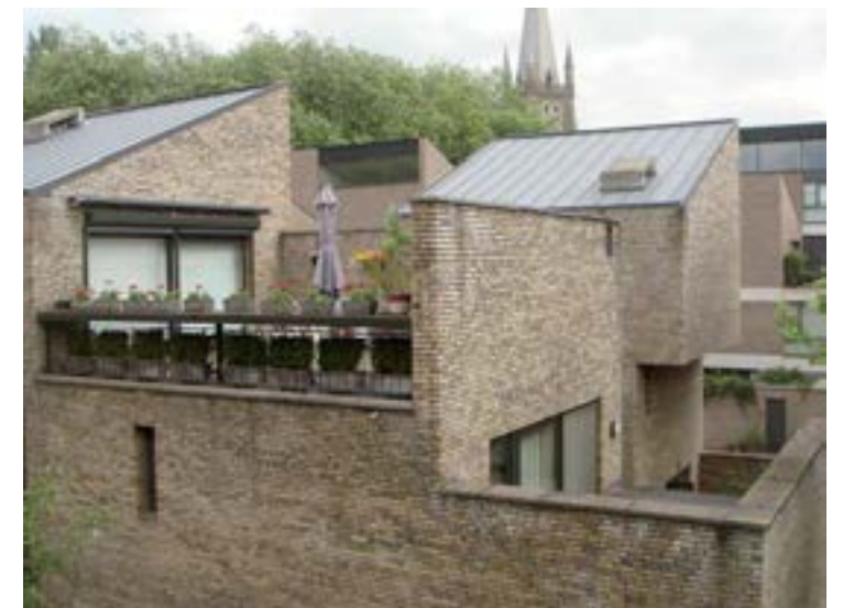
Exemple d'un ensemble bâti à Bruges
